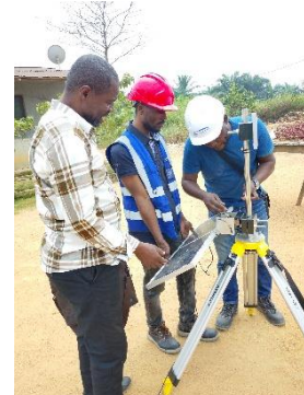
Photo 12 : Installation de l'appareil de suivi de la qualité de l'air
